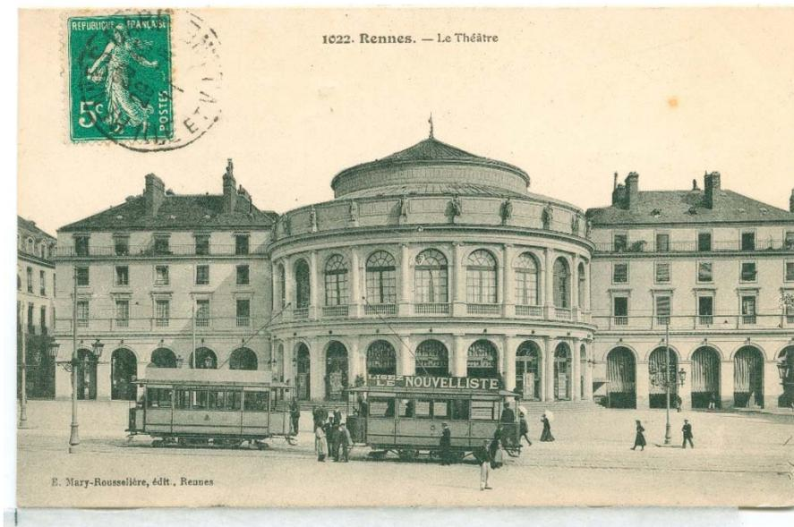
Le système de tramways proposé par Faye et Grammont est un système électrique sur rails et à fil aérien. Les câbles conducteurs sont portés par des fils transversaux en acier fixés sur des poteaux métalliques ou sur des rosaces attachées aux façades des maisons. Les voitures sont ainsi reliées au câble aérien au moyen d'une perche. Les voitures, quant à elles, reposent sur des trucks à suspension placés sur quatre roues, afin de franchir facilement des courbes de petit rayon.
